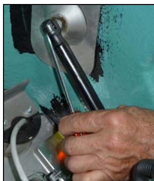
Fig. 10-9 Za pomocą wkrętka unieść klamrę i zwolnić sprężynę
